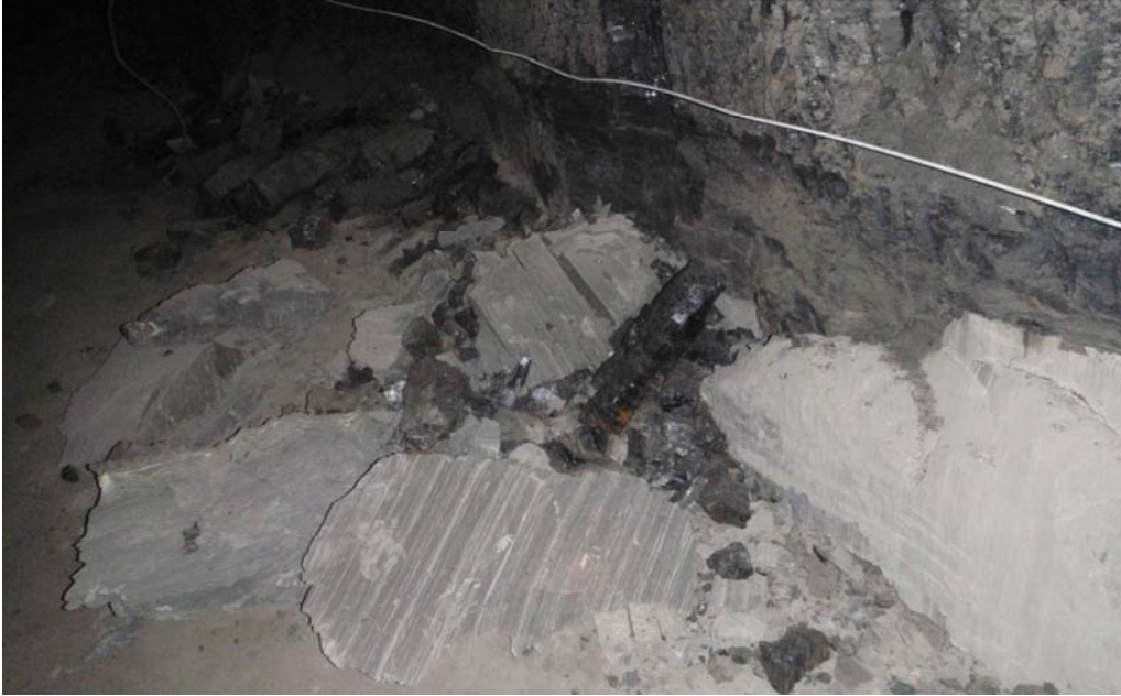
Рис. 4. Віджим і обвалення порід підшви пласта
