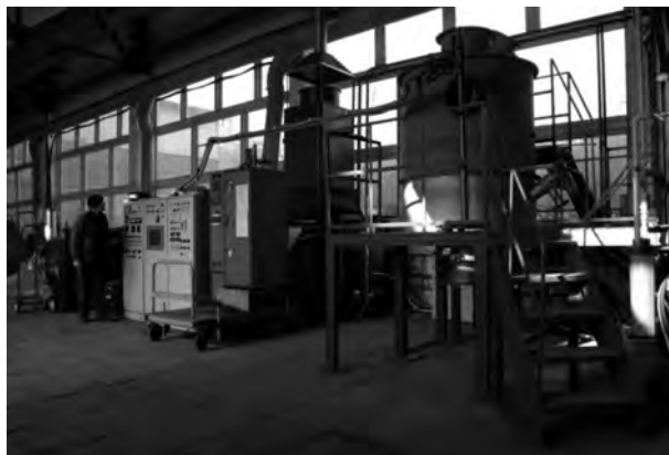
Рис.1. Корпус базового модуля реактора для плазменно-паровой переработки отходов производительностью не менее 200 кг/ч в стадии его монтажа.
