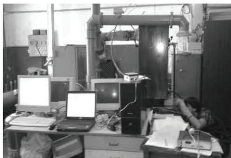
Рис. 3. Експериментальний стенд для дослідження кількості теплоти, що виділялась при спалюванні змішаних ТПВ.
