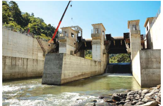
Рис. 4. Строительство гидроузла Тоачи-Пилатон. Эквадор
