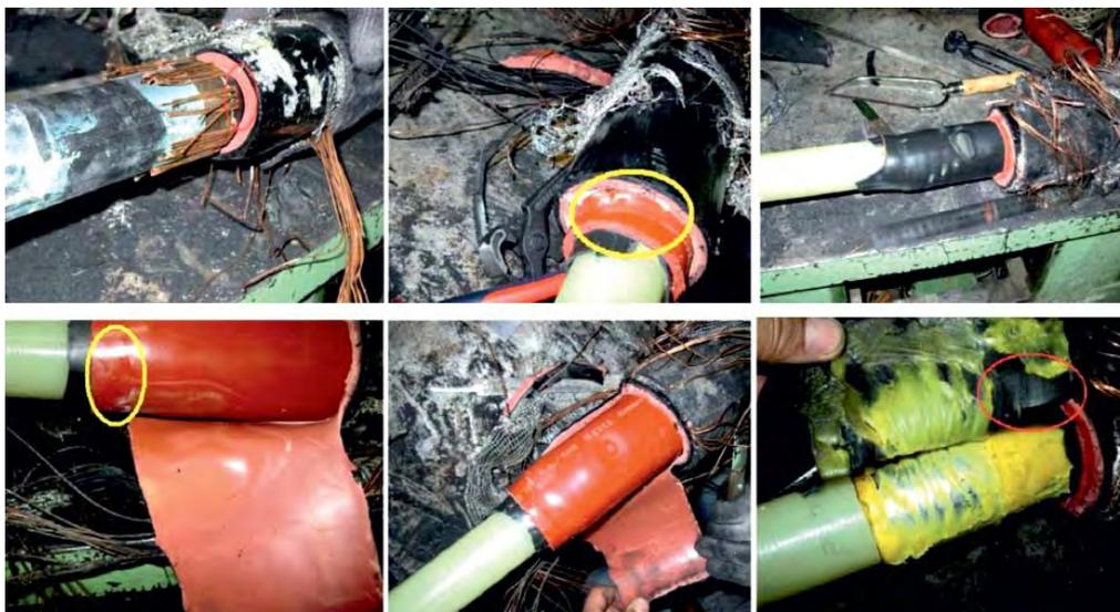
Рис. 26. Следы частичных разрядов в муфтах фирмы Raychem из-за некачественно выполненного монтажа [71].
