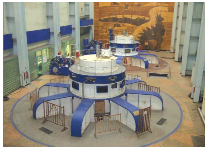
Рис. 1. Гидроагрегаты №1 и №2 после модернизации
