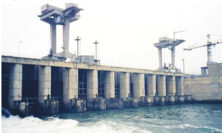
Рис. 1. Днестровская ГЭС-2. Кран козловой г.п. 2x150/30+20+1 т.
