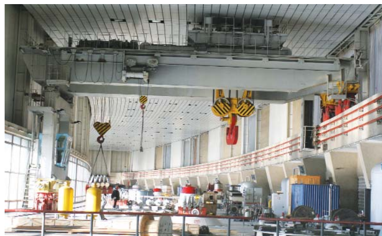
Рис. 3. ДнепроГЭС-2. Кран полукозловой г.п. 250/50/10 т.
