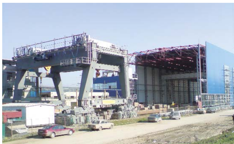
Рис. 2. Днестровская ГАЭС. Кран козловой г.п. 420+420+16 т.
