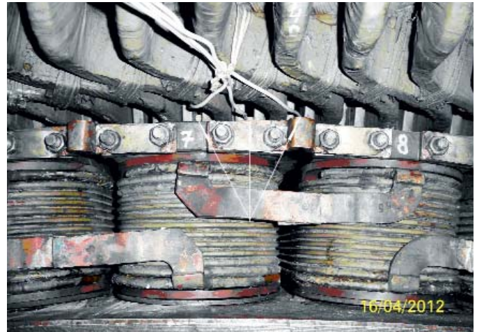
Рис. 3, б. Місця установки датчиків індукції (показані стрілками) магнітного поля в торцевій зоні гідрогенератора ст. №15 Київської ГЕС
