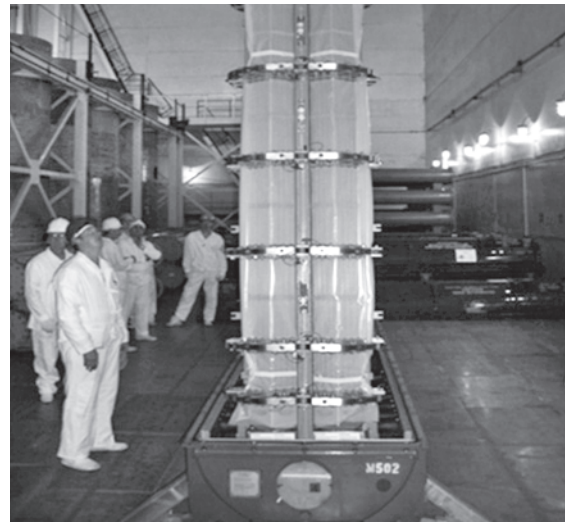
Рис. 2. Сверка номеров ТВСW и выгрузка ТВСW из транспортного контейнера
