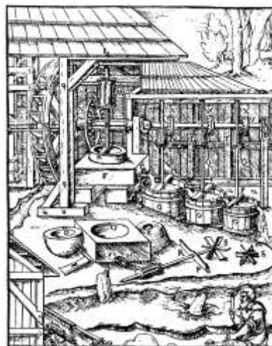
Мельница для дробления золотоносной руды в XVI веке
