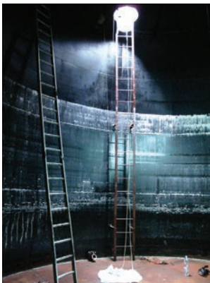
Рис. 2. Загальний вид внутрішньої стінки резервуара
