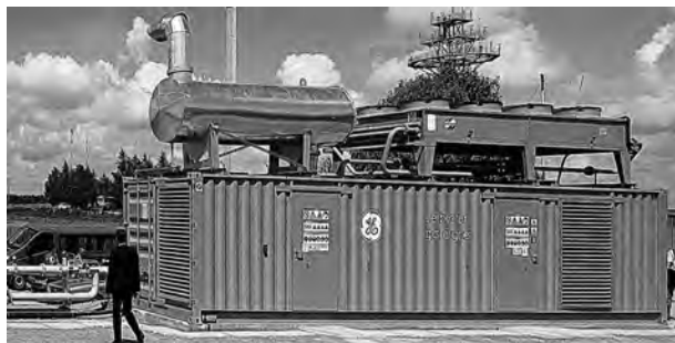
Рис.9. Бориспольская станция переработки свалочного биогаза в электроэнергию мощностью 1 МВт.
