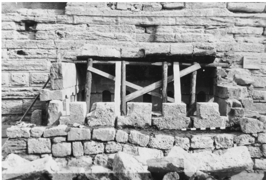
Рис. 12. Наружная сторона южной стены склепа № 1013 в процессе реставрации.
