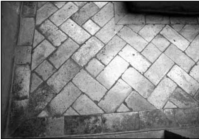
Рис. 18. Підлога покою палаццо Даванцаті, складена теракотовими прямокутними плитками «у ялинку»
