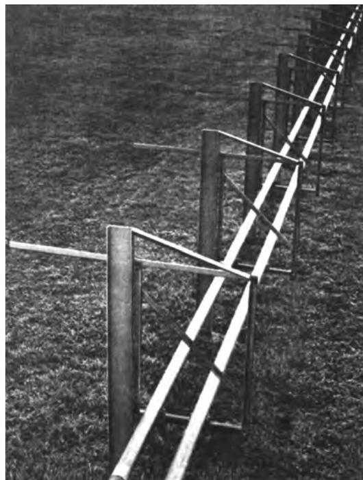
**Рис. 19.** Экспериментальная линия передачи энергии на основе круглого сверхразмерного волновода с волной  $H_{01}$  ( $f = 9$  ГГц). (Репродукция из работы [78])
