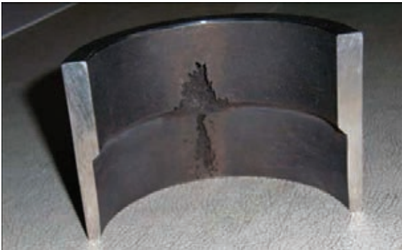
Рис. 3. Фрагмент трубопровода с кавитационной каверной (дефектом)
