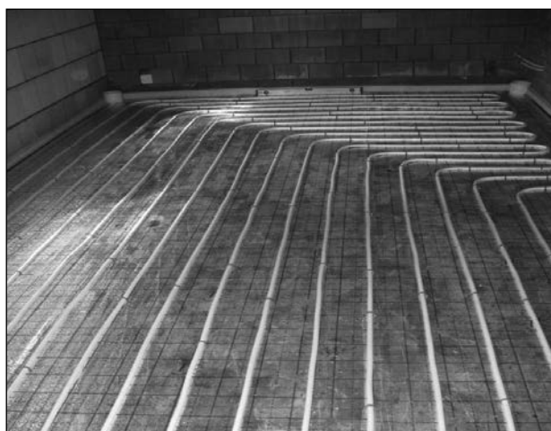
Рис. 16. Теплообмінник типу «контура водяна система підлогового опалення»
