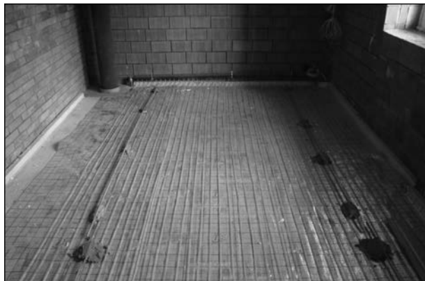
Рис. 17. Теплообмінник типу «капілярна водяна система підлогового опалення»
