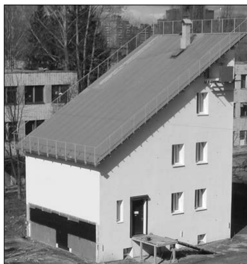
Рис. 1. Зовнішній вигляд експериментального будинку пасивного типу на стадії будівництва
