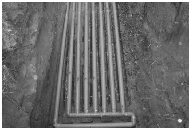
Рис. 14. Теплообмінник типу «грунт—повітря»
