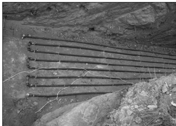
Рис. 13. Теплообмінник «8 ниток» типу «ґрунт–вода»
