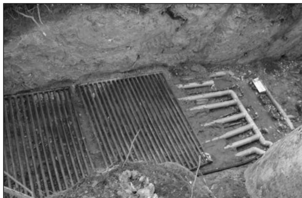
Рис. 15. 3-секційний багатоходовий теплообмінник типу «грунт—вода»
