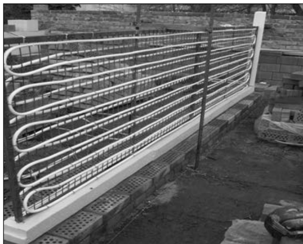
Рис. 19. Монтаж теплообмінника, вмонтованого в бетонний простінок
