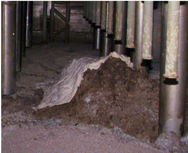
Рис. 1. Скопление ЛТСМ, частично укрытое «ЭКОР-25ММ» (белая пленка), в помещении 012/7.
