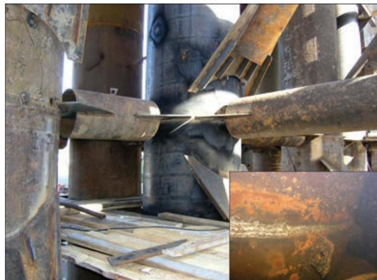
Узел крепления горизонтальных и диагональных связей к трубе
