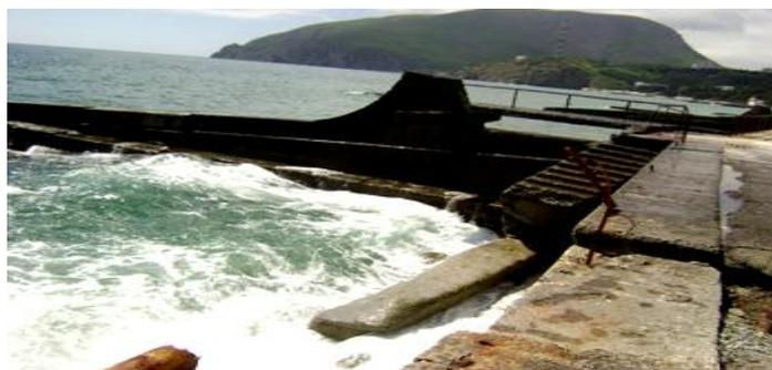
**Рис. 1.** Разрушение гидротехнической стены набережной пос. Карасан
