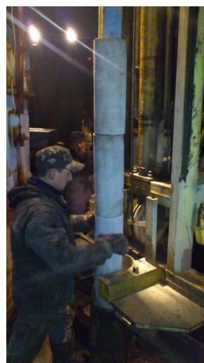
Рис. 4. Спуск КГФ в скважину
