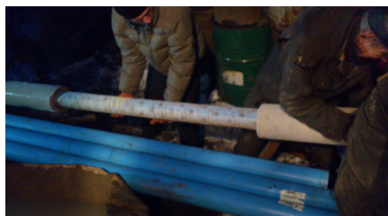
Рис. 3. Сборка криогенно-гравийного фильтра
