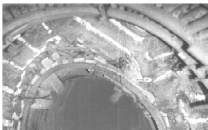
Рис. 1. Состояние полевого штрека гор. 915 м шахты им. К.И. Поченкова
