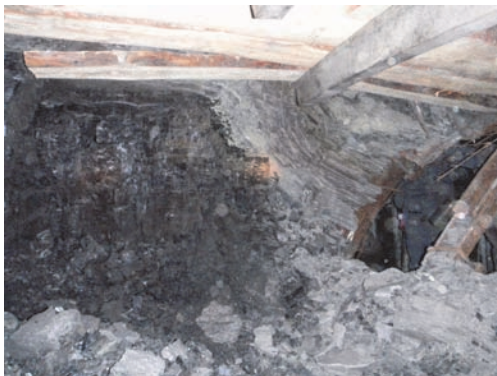
Рис. 2. Состояние горного массива в бортах выработки в условиях шахты «Степная»
