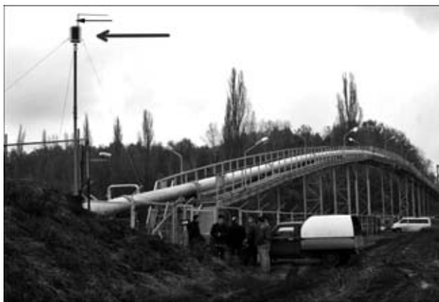
Рис. 4. Мачта с солнечной батареей (показана стрелкой) и выносной антенной GSM модема в начале компенсатора мостового перехода
