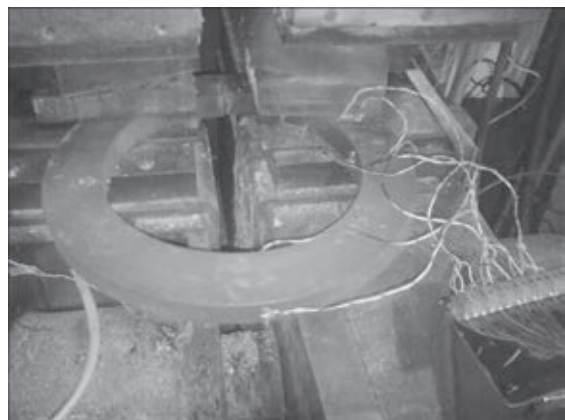
Рис. 2. Контактная стыковая сварка стального кольца ( a = 135 мм, b = 190 мм) на машине К724
