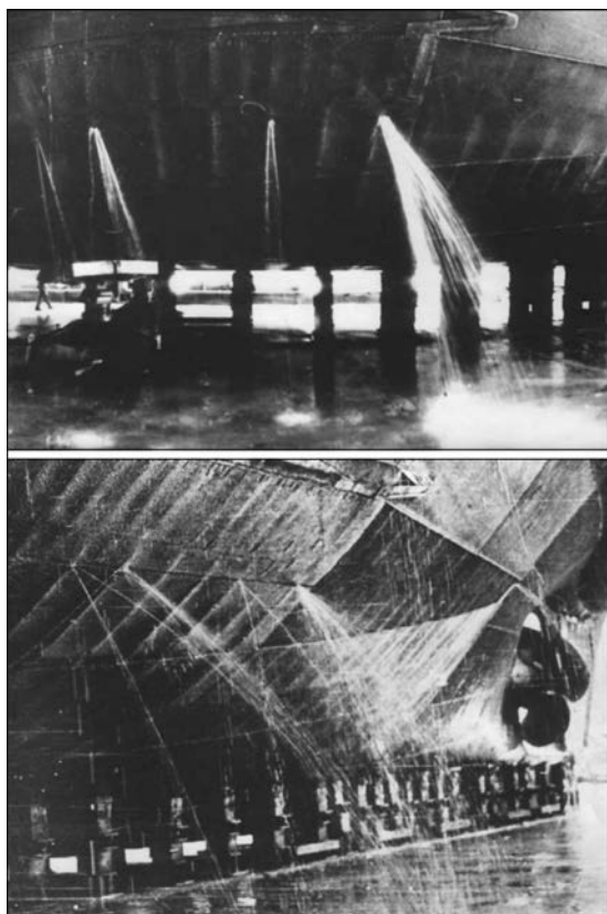
Коррозионные повреждения (свищи) наружной обшивки подводной части паромов «Сахалин» первого поколения
