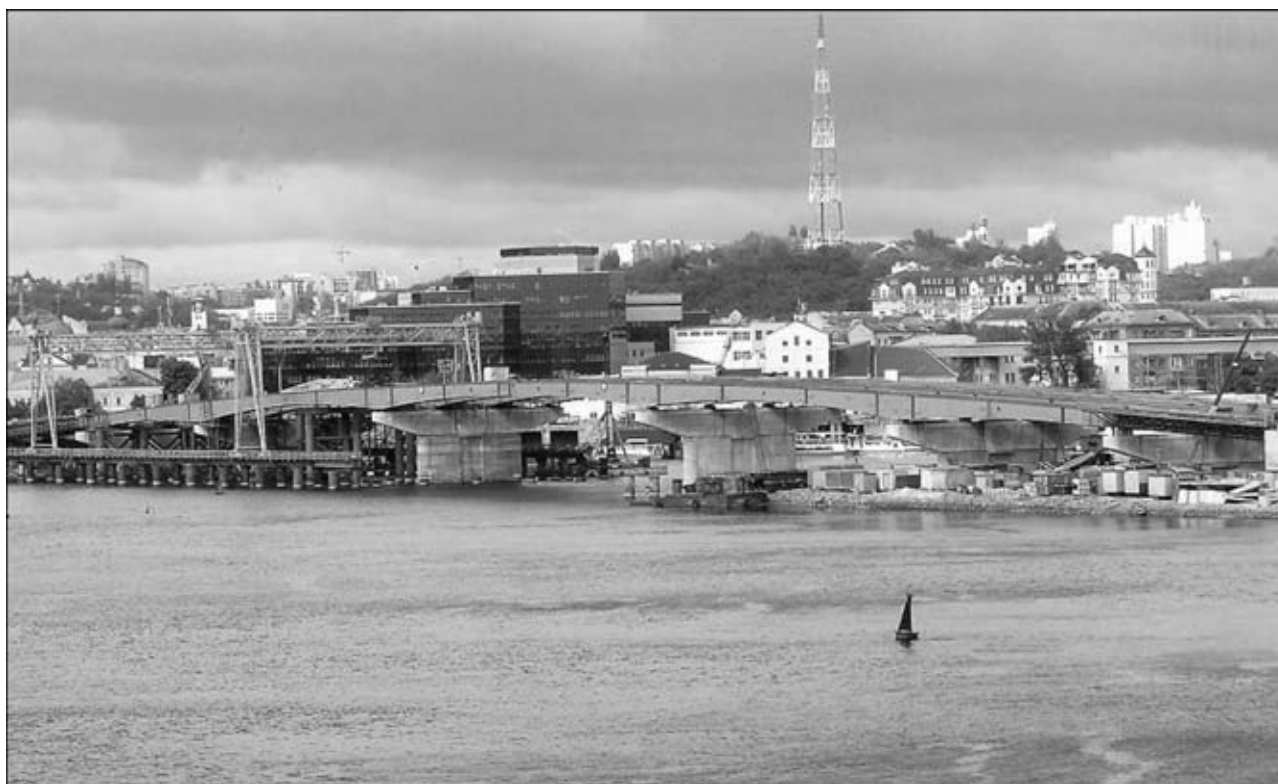
Строительство автомобильного моста через вход в Гавань (р. Днепр г. Киев)
