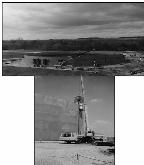
Рис. 8. Корпусные стенки резервуаров, подготовленные для автоматической сварки при монтаже
