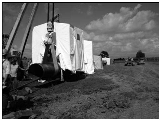
Рис. 1. Сварочная колонна фирмы CRC для автоматической сварки монтажных стыков
