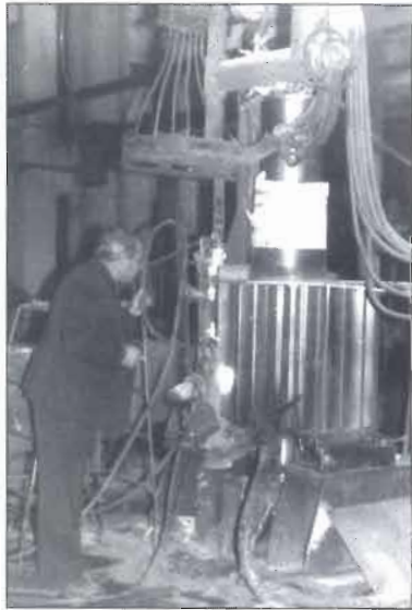
Рис. 3. Фрагмент восстановления зубьев подвешивочной вал-шестерни ( m = 40, z = 21 ) с применением ЭШН
