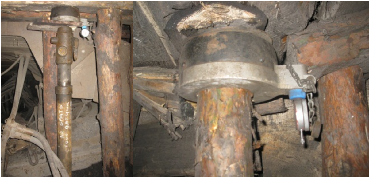
Рис. 10. Измерение нагрузки действующей на охранное сооружение
