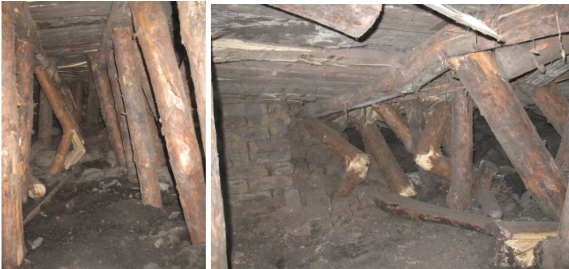
Рис. 8. Деформации стоек
