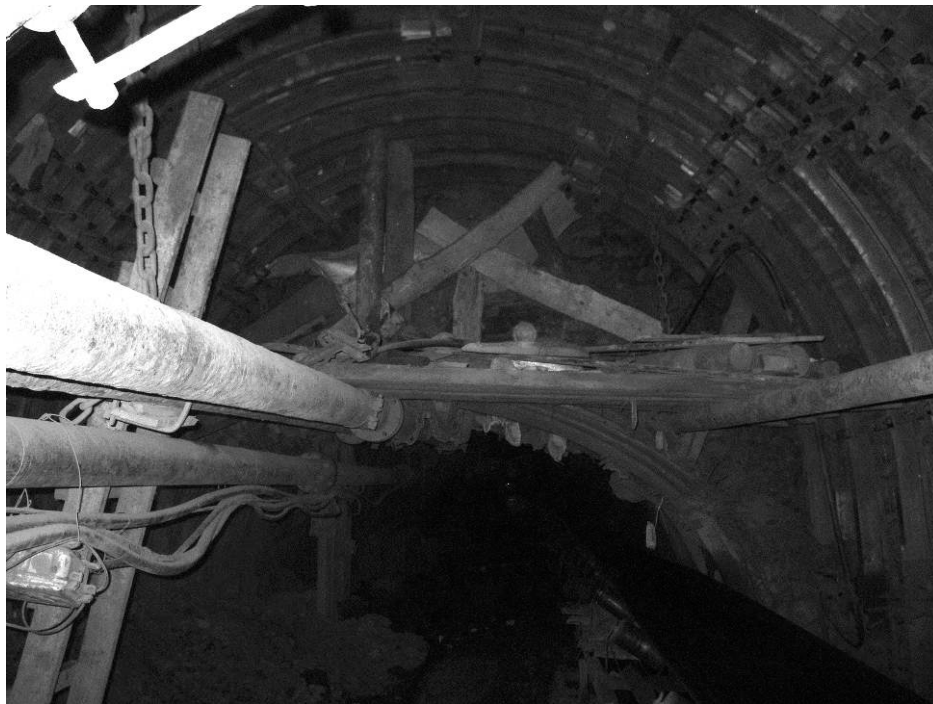
Рис. 3. Общий вид забоя перекрепления в конвейерном штреке 5 восточной лавы пл. m_3 гор. 915 м шахты «Щегловская-Глубокая»
