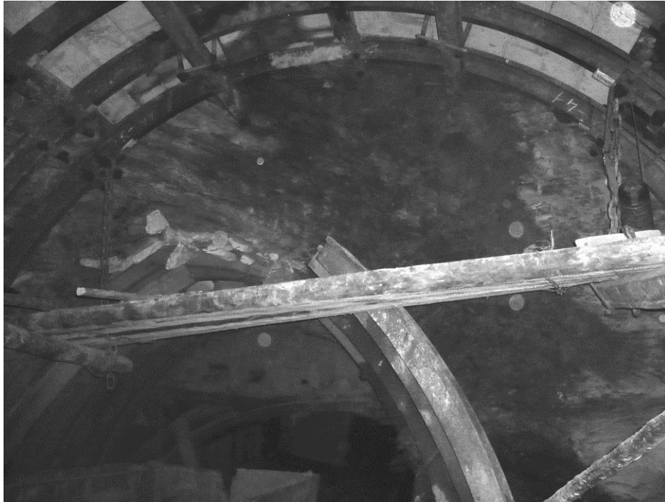
Рис. 1. Общий вид забоя перекрепления во вспомогательном уклоне пласта m_2
