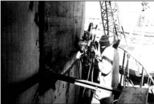
Рис. 3. Автоматизированная сварка горизонтального шва стенки резервуара аппаратом АД-330М
