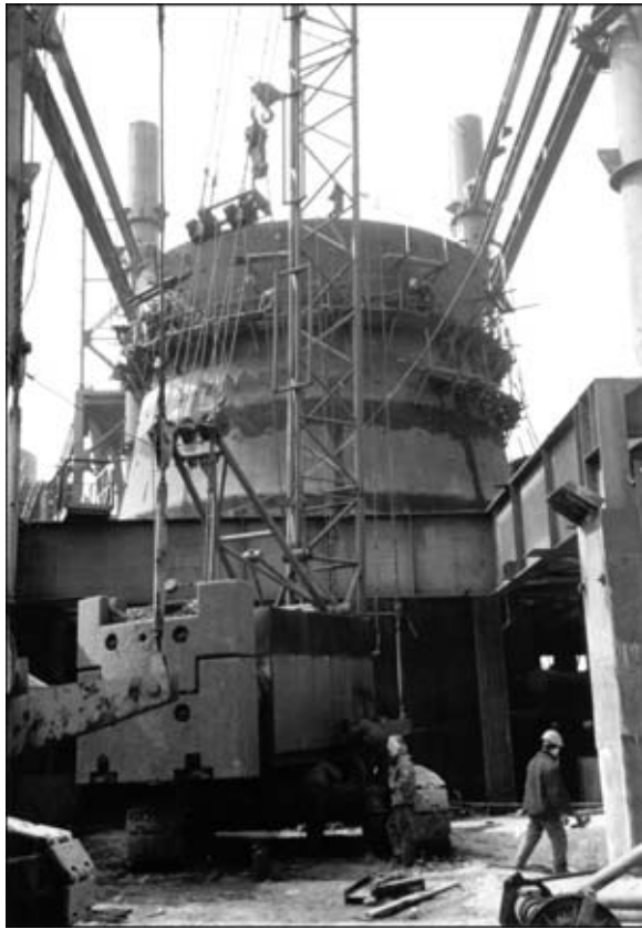
Рис. 3. Сооружение доменной печи ДП-2 на ОАО «Азовсталь»
