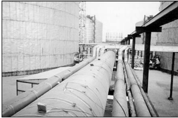
Рис. 2. Участок трубопровода с установленными датчиками для определения коэффициента затухания УЗ колебаний
