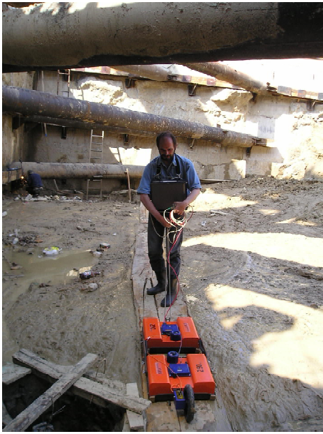
Рис. 12. Георадарное зондирование в котловане
