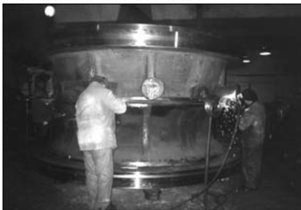
Рис. 6. Сварка чаши мельницы
