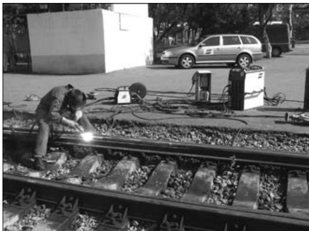
Наплавка рельсовых окончаний порошковой проволокой ОК Tubrodur 15.43
