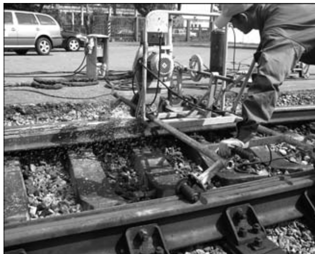
Зачистка восстановленного участка рельса
