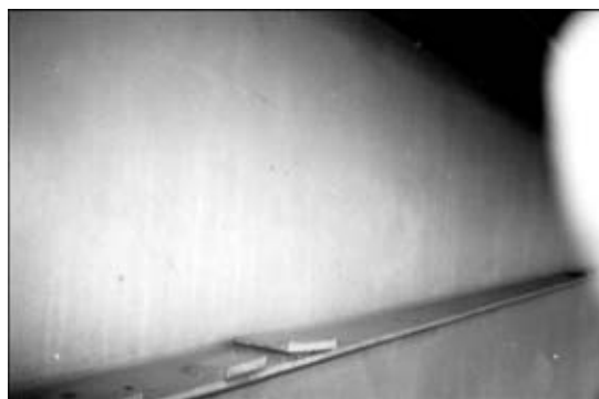
Рис. 4. Приварка фланговыми угловыми швами временных сборочных приспособлений к продольным ребрам главных балок моста им. Е. О. Патона
