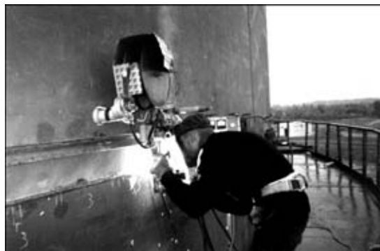
Выполнение сварки горизонтального шва
