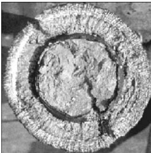
Рис. 8. Вид реза многослойной трубы основания морских стационарных платформ
