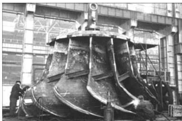
Рис. 8. Подготовка к ЭШС колеса гидротурбины для Асуан- ской ГЭС на Ленинградском металлическом заводе (1965)
