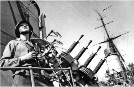
Рис. 2. На крейсере «Молотов», 1943 г. [5]. Стрелкой показана антенна радиолокатора «Редут-К»
