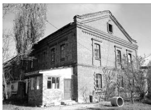
Рис. 5. Неокласицизм. Заводська контора цукрово-рафінадного заводу у місті Бердичеві Житомирської обл.
