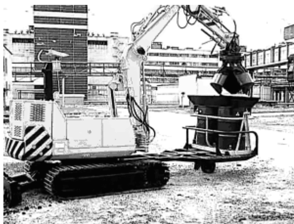
Рис. 1. Извлечение обнаруженных сыпучих ВАО (на заднем плане видны кабинки операторов) и загрузка их в первичные упаковки КТ-02.
