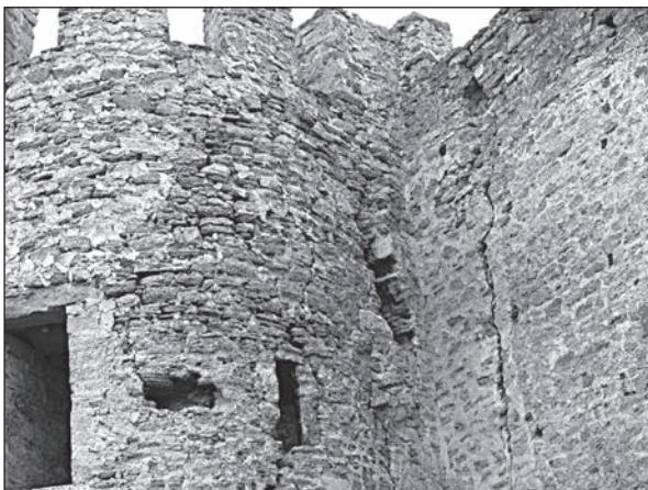
Рис. 3. Деталі руйнації башти № 25 (фото 2005 р.)
