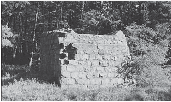
Мостова споруда недобудованої залізниці на поселенні між Ходосівкою та Лісниками
