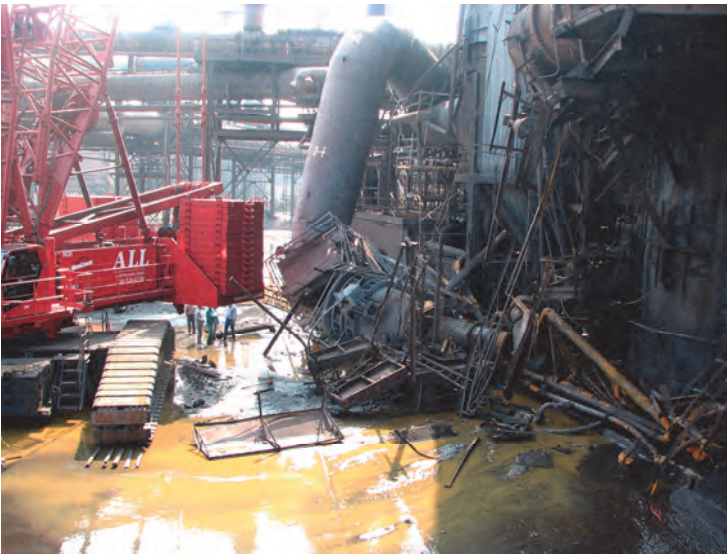
Рис.1. Авария на выдувке доменной печи D, Burns Harbog (США) в 2008 г.
