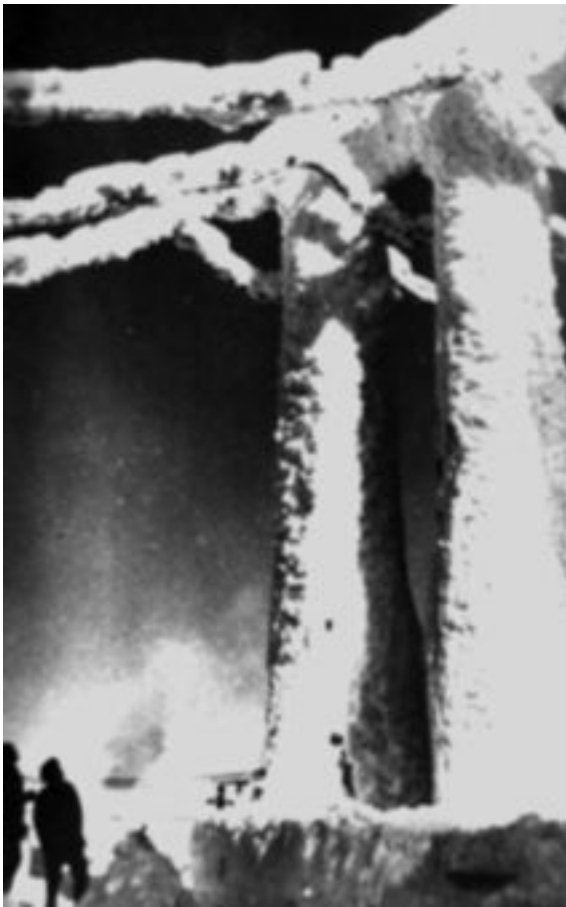
Рис. 3. Состояние линии электропередачи после снежной бури в Павлодарской области.
