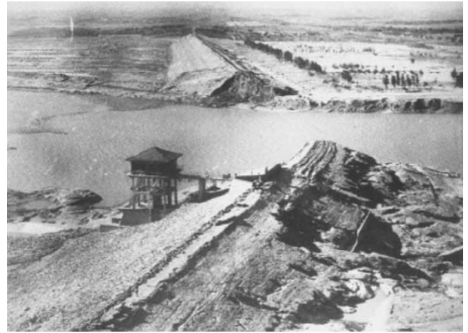
Рис. 2. Вид на зруйновану греблю Баньцяо (Китай, 1975 р.) [7]
