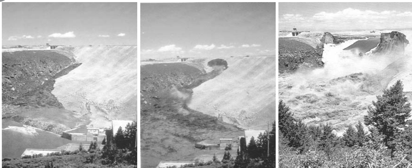
Рис. 5. Руйнування греблі Тетон (США, 1976 р.) [12]
