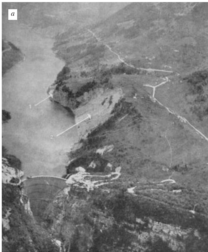
Рис. 6. Вид на аркову греблю Вайонт та долину р. П'яве (Північна Італія) до (а — стрілочками показано тіло зсуву) і після (б — верхній, в — нижній б'єфи) аварії 1963 р. [17]
