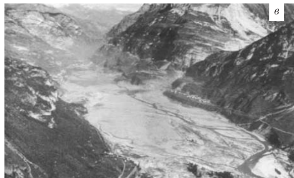
Рис. 6. Вид на аркову греблю Вайонт та долину р. П'яве (Північна Італія) до (а — стрілочками показано тіло зсуву) і після (б — верхній, в — нижній б'єфи) аварії 1963 р. [17]
