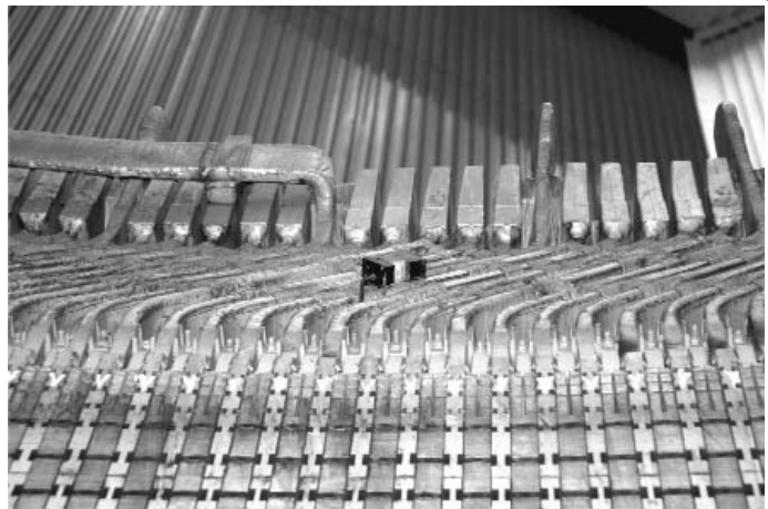
Рис. 4. Датчики вибрации лобовых частей фирмы Ортоakustiks обмотки статора ГД-1 Днестровской ГАЭС
